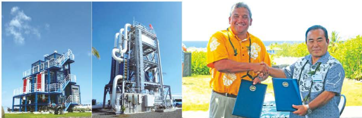
ハワイの海洋温度差発電実証設備、沖縄の同実証設備
